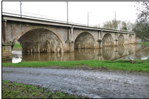
Pont de chemin de fer de Cambré longueur 96 mètres, inauguré en 1861
